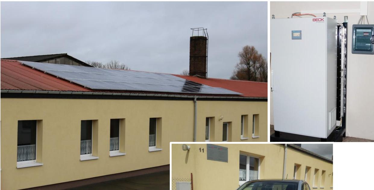
Auf dem Dach der Begegnungsstätte in Kublank wird Strom produziert. Dieser wird in einem Batteriespeicher (rechts) zwischengespeichert. So kann das Dorfauto auch geladen werden, wenn keine Sonne scheint.
